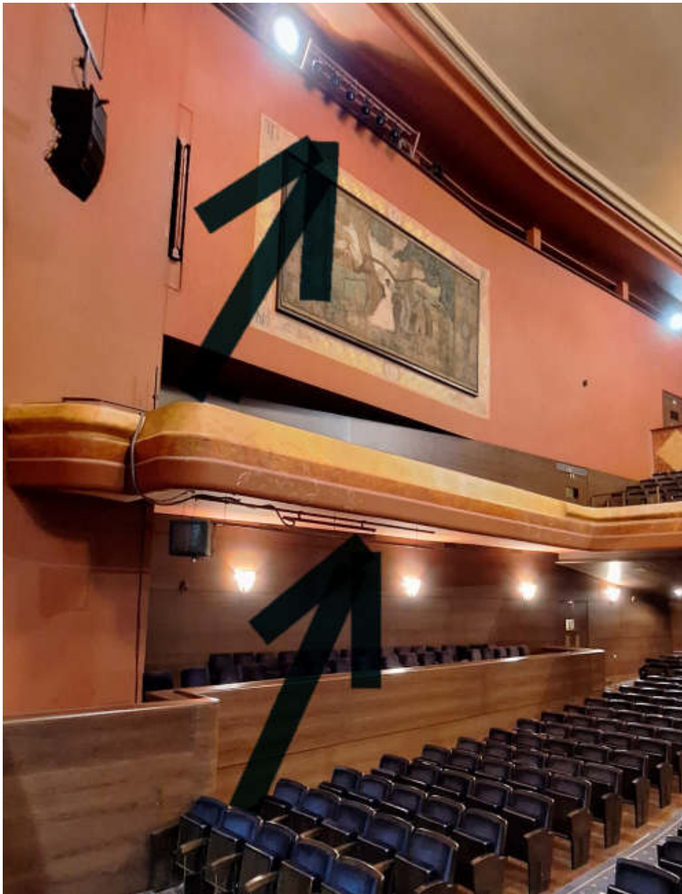
Cerchas para colocación de focos laterales.
