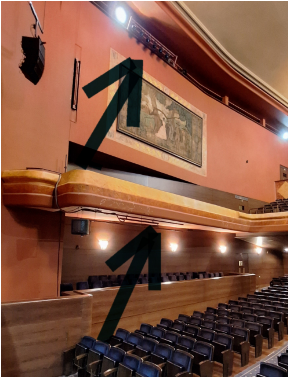
Cerchas para colocación de focos laterales.
